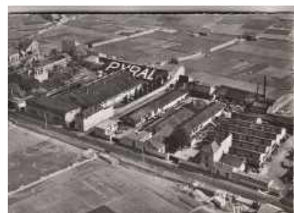
Aerial view of the Pyral Plant, Rue de l'Echat, Créteil
